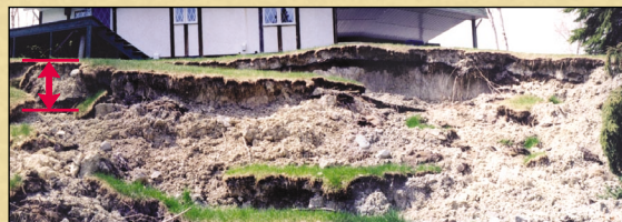
Remblai de terre au sommet d'un talus
