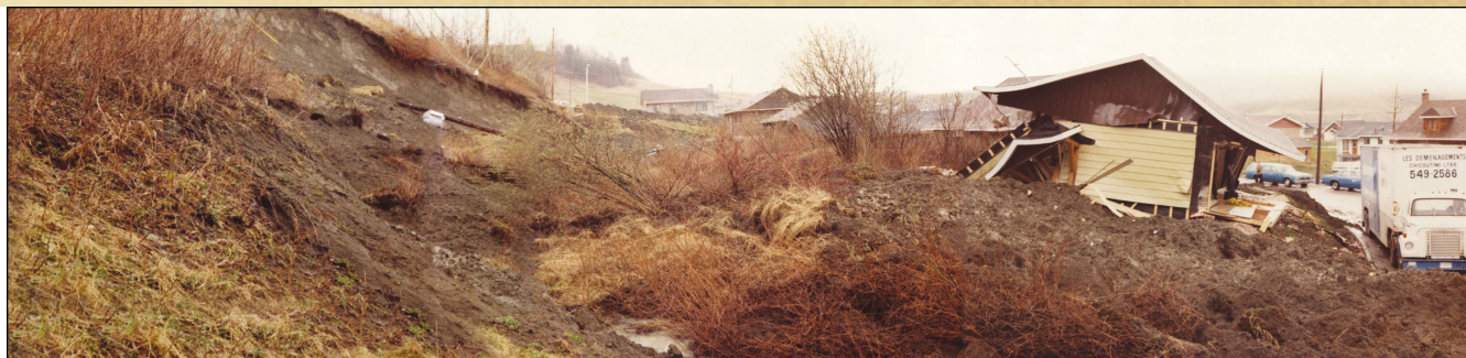
Les débris d'un glissement ont détruit ce bungalow en le heurtant.
