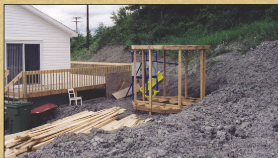
Déblai à la base d'un talus afin de construire une terrasse
