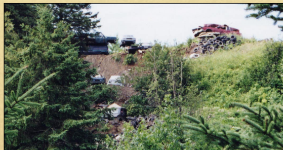
Entreposage de rebus trop près du sommet du talus
