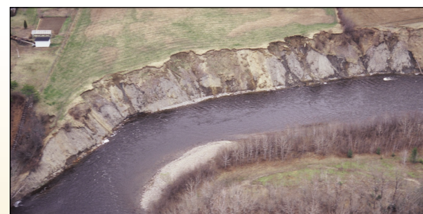
Glissements causés par l'érosion à la base des talus
